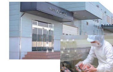
水産加工施設 (宮城県気仙沼市)
