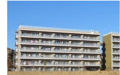
災害公営住宅 (宮城県石巻市)
